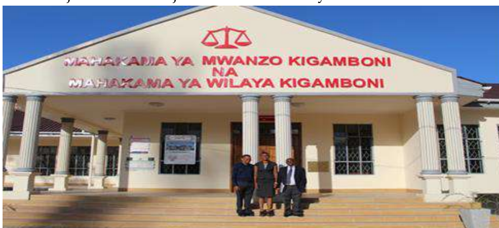
Mwonekano wa Jengo la Mahakama ya Mwanzo na Wilaya - Kigamboni
